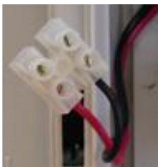
Рисунок 12. Кабель для подключения замка к источнику питания.
