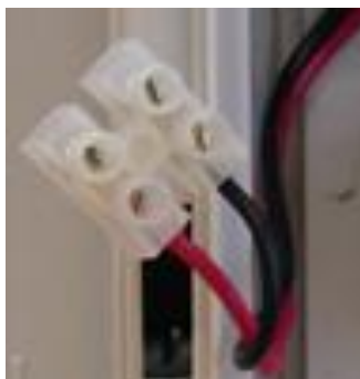
Рисунок 10. Кабель для подключения замка к блоку питания
